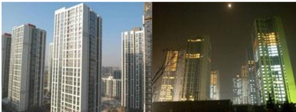
(奥运媒体村二期工程全景) (奥运媒体村二期工程夜景)
