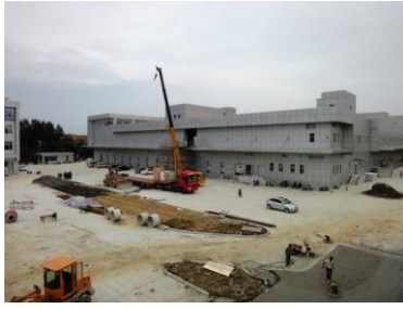
建设中的西南航食配餐楼
