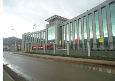
玉龙铜矿办公楼
