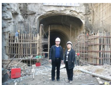
普西桥水电站泄洪冲沙洞进口
